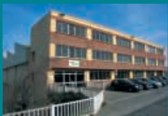
Instalaciones en el Elkartegi de Mungua (1985)
